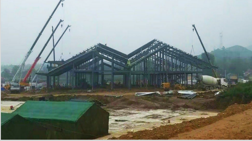
Ana elik yapının tamamen kaldırılması1. ay
